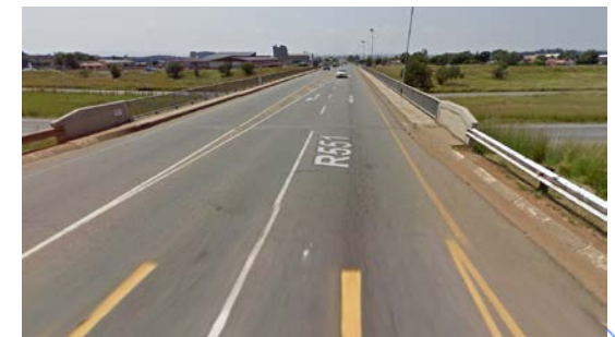
Bridge over Sybrand van Niekerk (Johan Le Roux Road)
